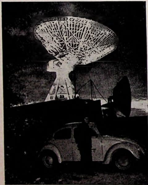
DE 25 m PARABOOL VAN DE RADIO- TELESCOOP OP DE STOCKERT (Eiffel). Op de voorgrond één van z'n kleine broer- tjes als antenne van de straalzender, tijdens een televisieuitzending voor deze radio-ster- renwacht. (Foto: Telefunken).
